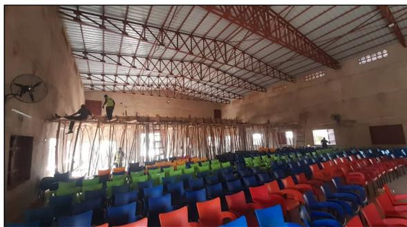
*Dopo la posa del tetto sono iniziati i lavori per la creazione di un soppalco per aumentare la capienza del locale, già insufficiente. L'armatura del solaio è eseguita con pali di eucalipto.*
